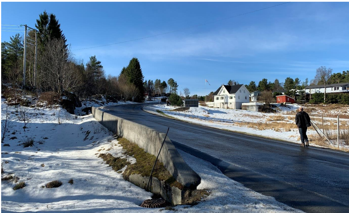
Figur 7: Bilde tatt fra gamle kraftstasjonen
