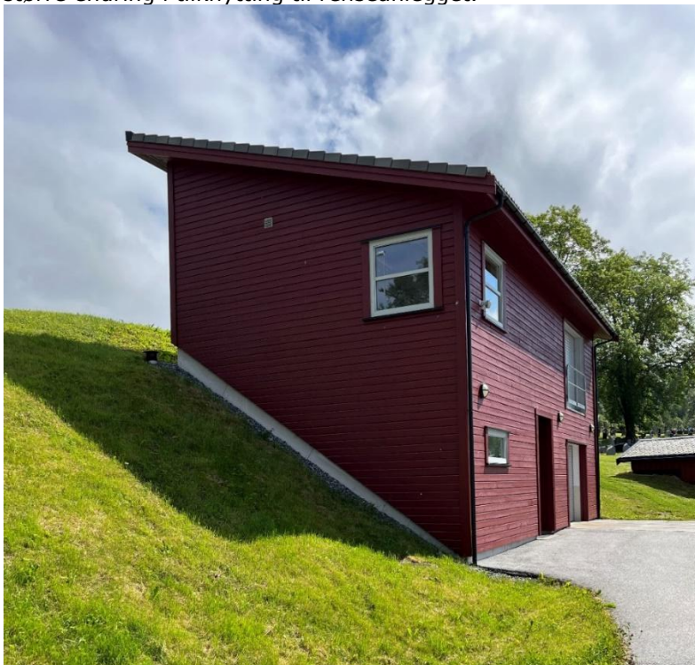
Figur 16: Sentrum renseanlegg (Foto Rambøll, 26.06.2024)
