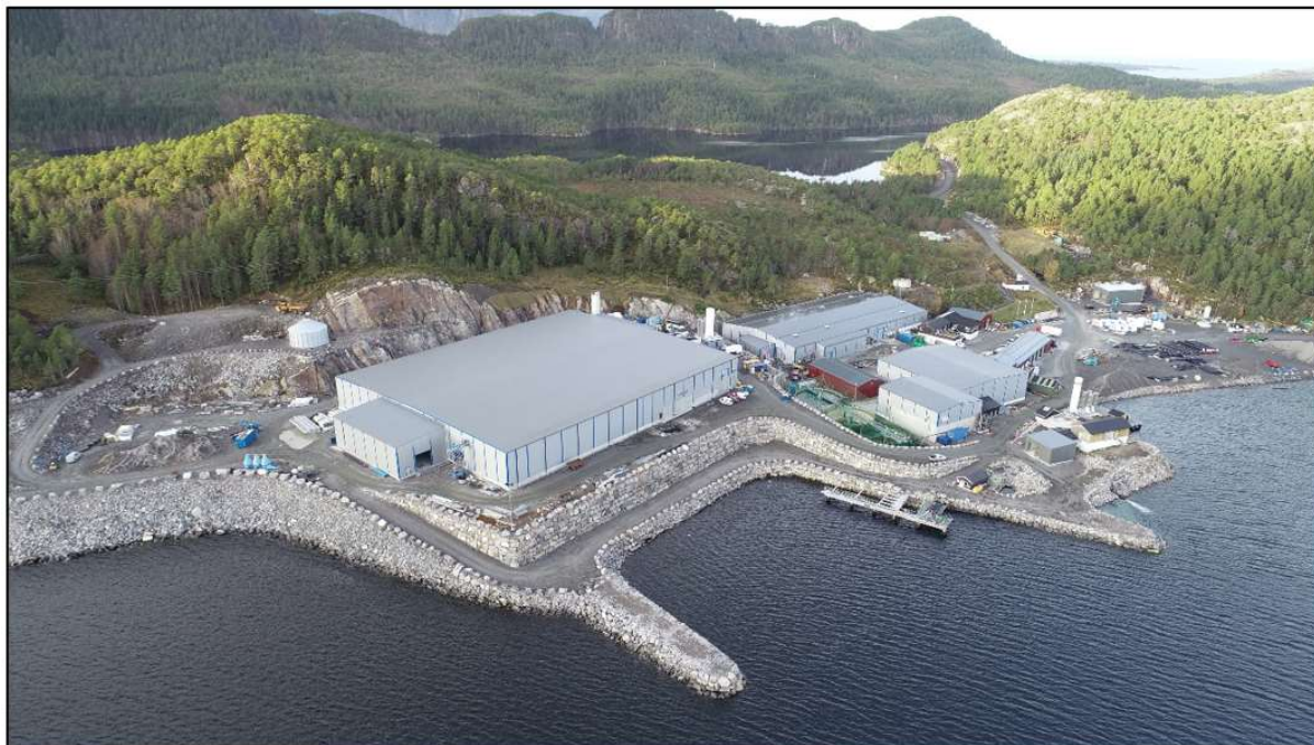
Figur 2: Skråbilde som viser etablert produksjonsanlegg på Nordheim (høsten 2018). Sagvikvatnet øverst i bildet. Foto: Mowi ASA
