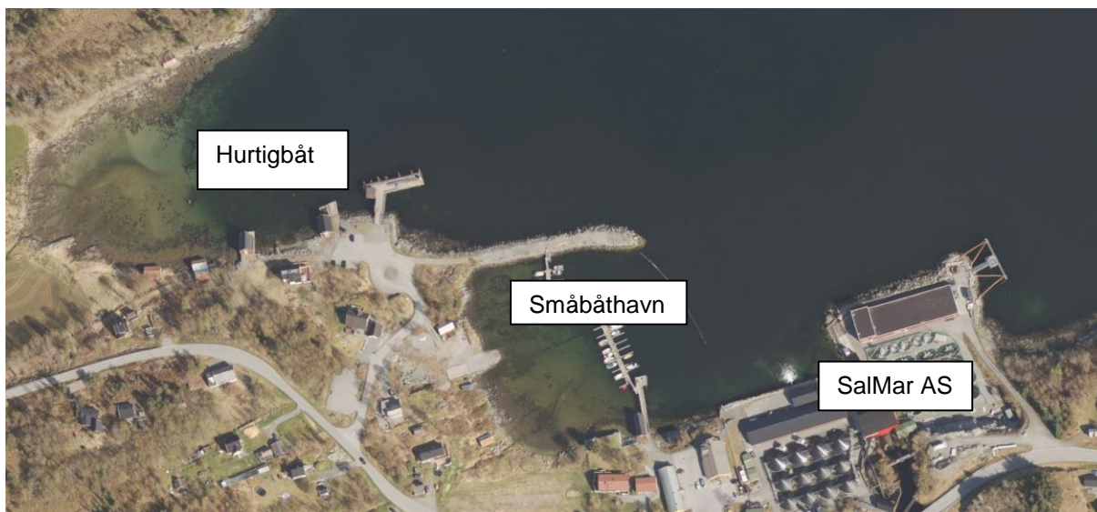
Figur 5: Kaianlegg i Kjørsvikbugen. Flyfoto av 12.05.2017.
